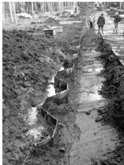
... impose un chantier conséquent
