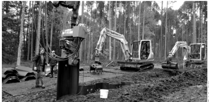
Une retenue en palplanches au cœur d'une tourbière ...
